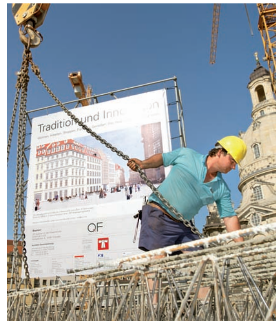
Herbouw centrum Dresden; kan alleen met partners.
