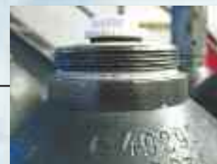
Inwendige controle, opnieuw spuiten, nieuwe inslag, nieuwe kraan
