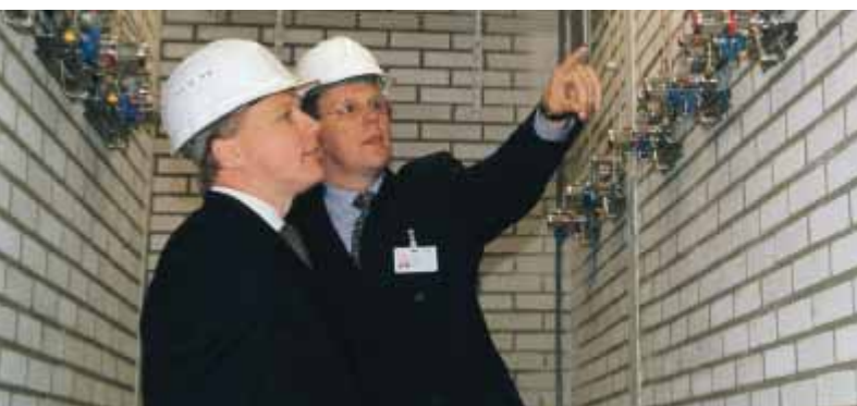
HoekLoos-functionarissen controleren het kersverse leidingwerk voor speciale gassen.
