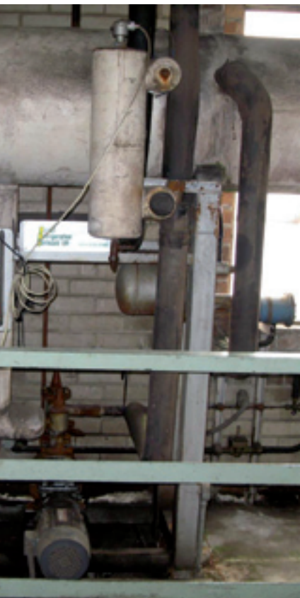
foto 2 : Het lagedruk buffervat met de Witt vloeistof pomp.
