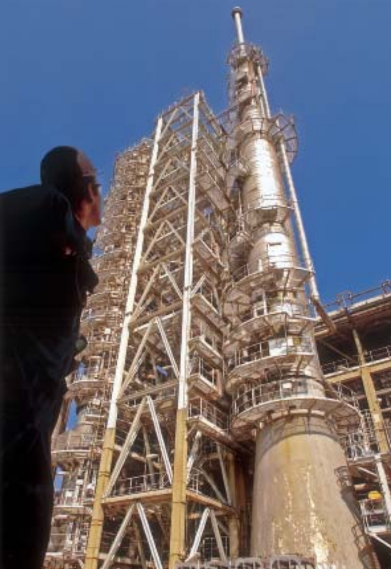
Via deze installatie in de Rijnmond lost Shell CO 2 . Die uitstoot gaat aanzienlijk verminderen dankzij het glastuinbouwproject.
